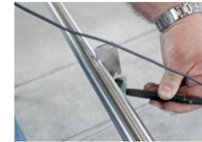
Entfernen der Verfärbungen, die durch das Schweißen entstanden sind
