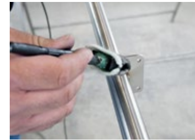
Entfernen der Verfärbungen, die durch das Schweißen entstanden sind
