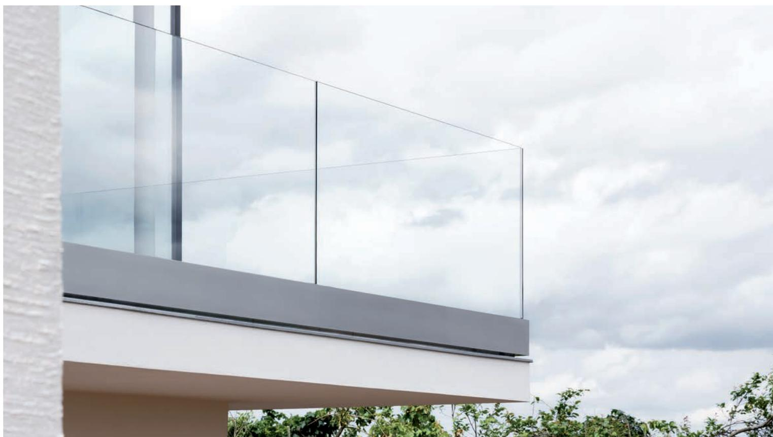
(2) Die horizontalen Nutzlasten nach Tabelle 6.12DE sind in Absturzrichtung in voller Höhe und in der Gegenrichtung mit 50%, mindestens jedoch 0,5kN/m, anzusetzen.
